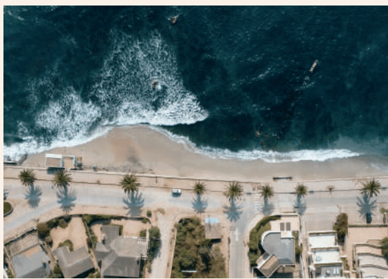
Fig 28. Toma aérea actual zona propuesta
